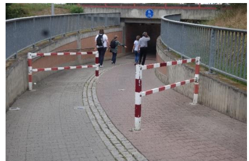
Abbildung 5: Umlaufsperrn an der Unterführung am Weiterstädter Bahnhof
