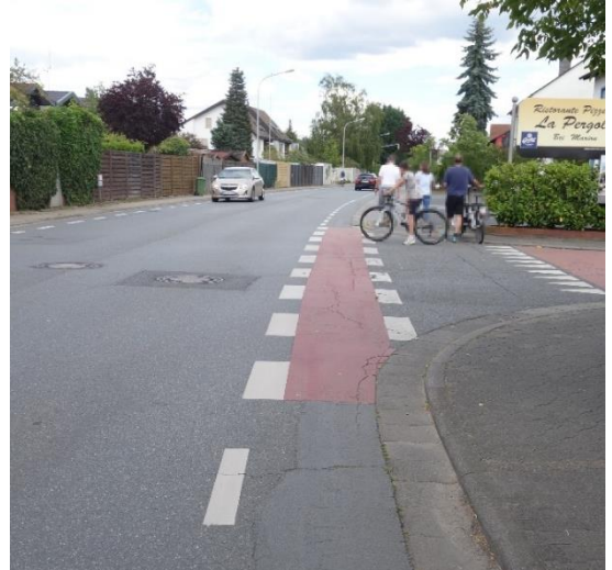
Abbildung 12: Schutzstreifen in der Rudolf-Diesel-Straße
